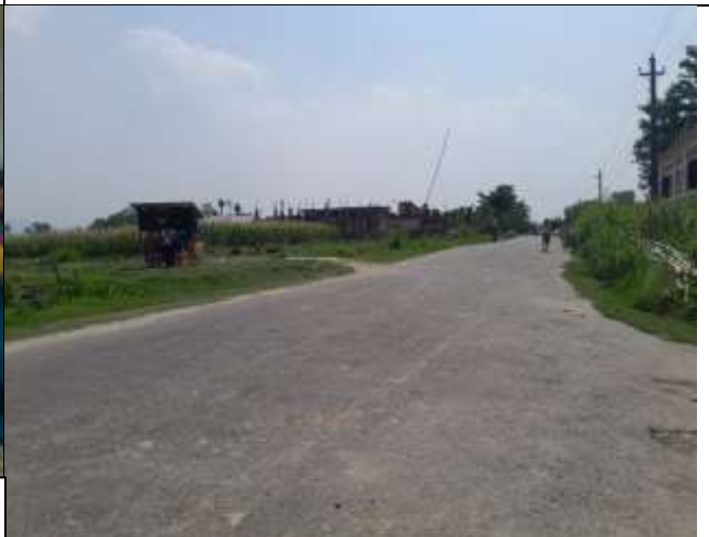
वडा नं ६ मा निर्माण भएको राप्ती गाउँपालिकाको चक्रपथको अवस्था
